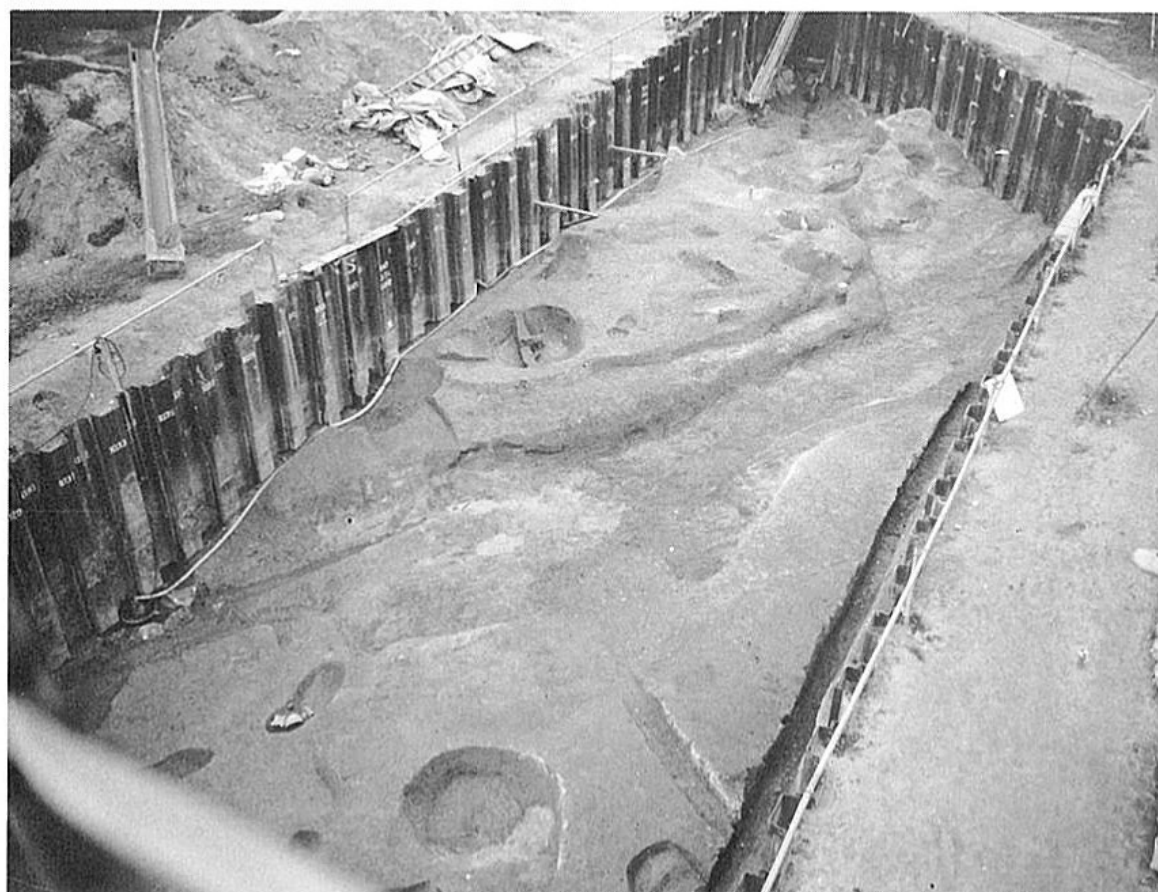
左：溝群掘り上げ全景 左上(←南)、左下(←北東)
