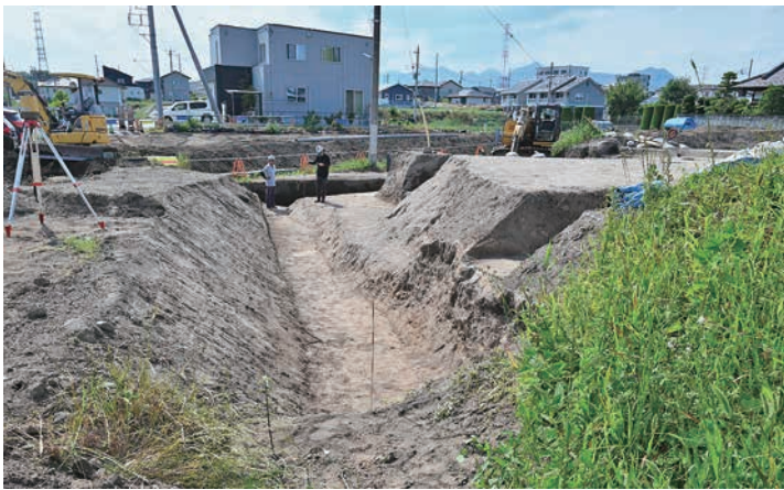
W-3 調査状況 (東から)
