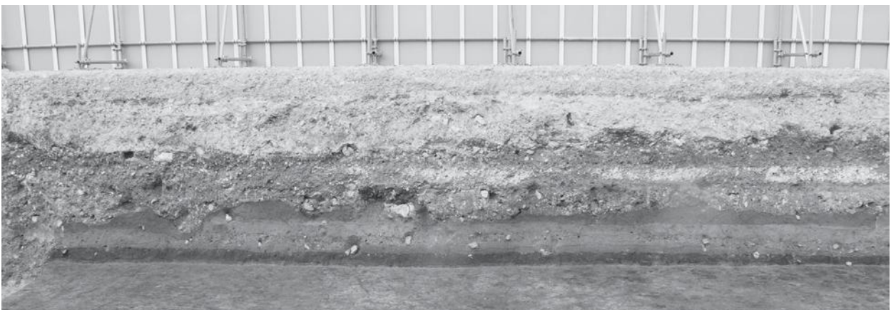
4.1区追加調査2・3 西壁断面（東から）
