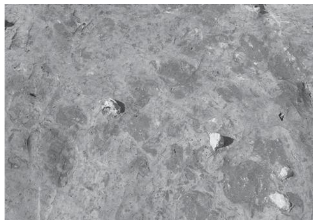
5. 1区 地震による変形状況（南東から）
