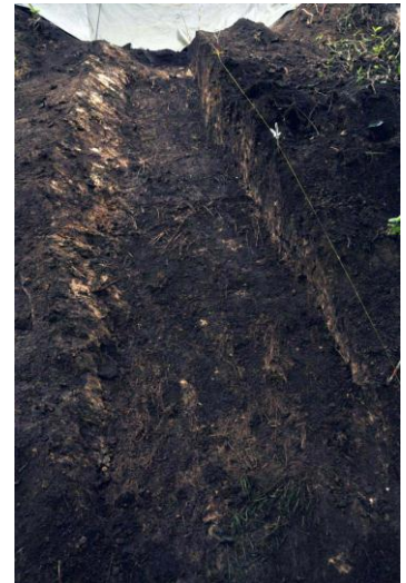
崩落箇所の土層堆積 (北西から)
