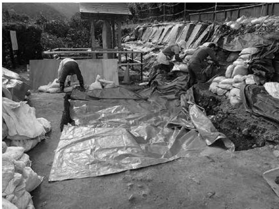
写真125 調査区1 埋め戻し状況②
