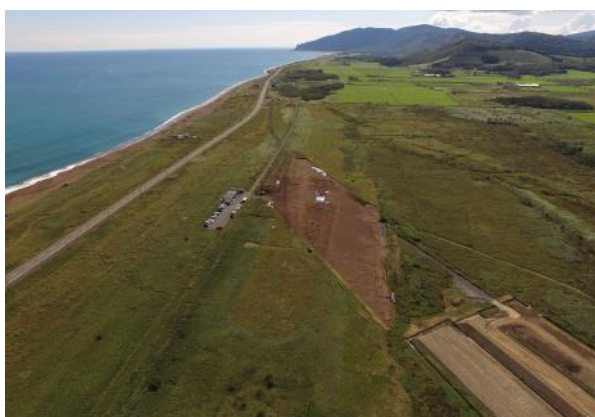
調査区全景（北西方向から撮影）
