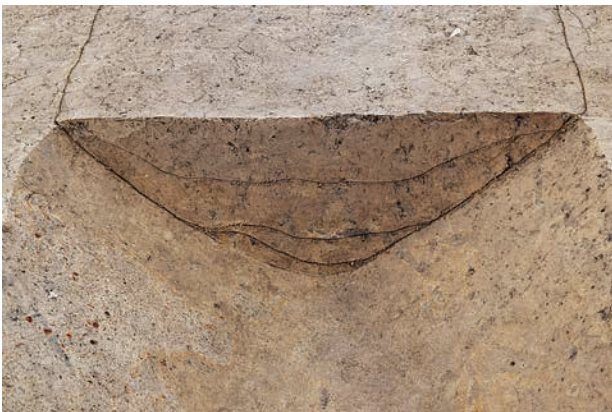
SD301 断面 A (北東から)
