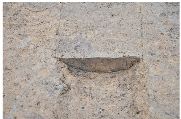
SD327 断面A (西から)
