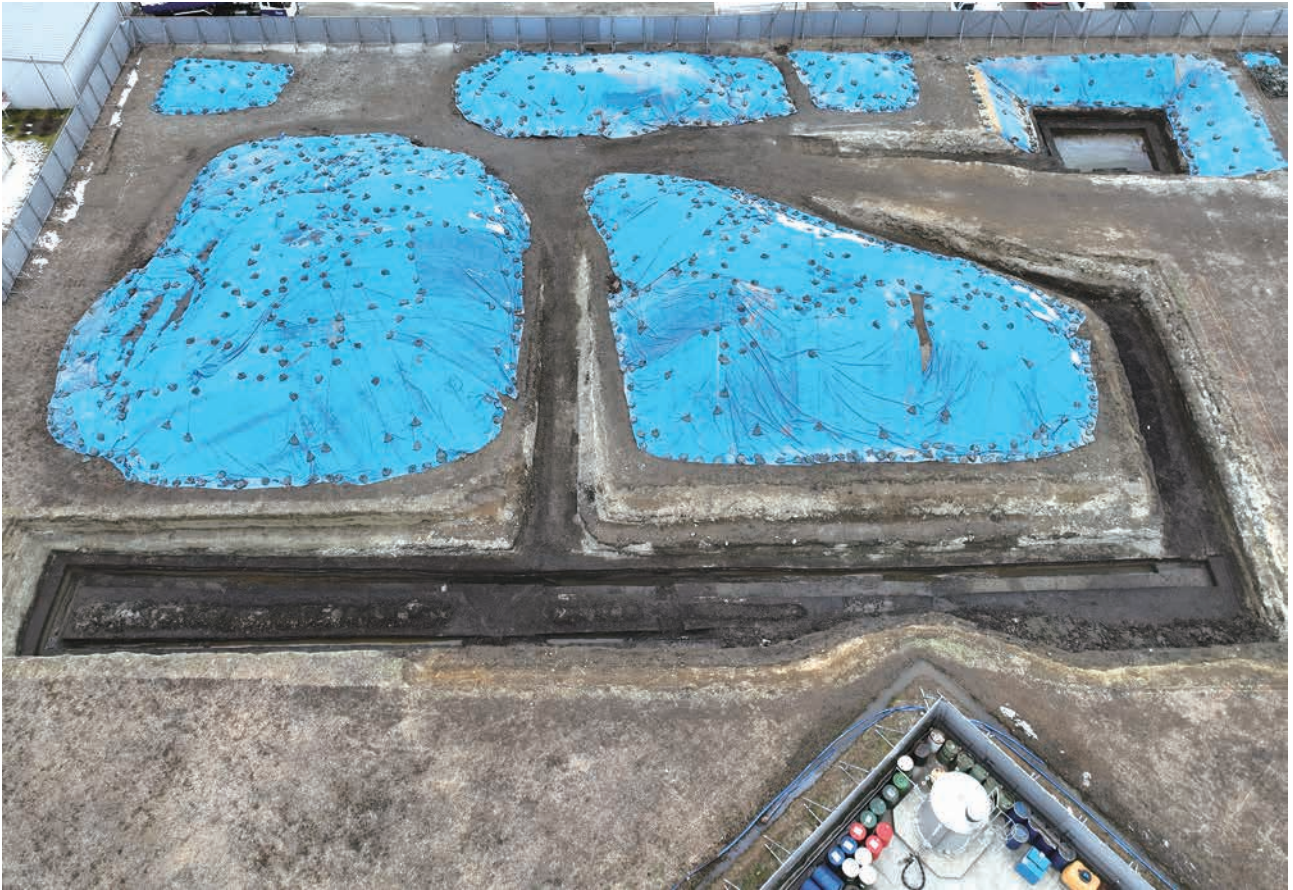
B区 調査完了状況（南から）
