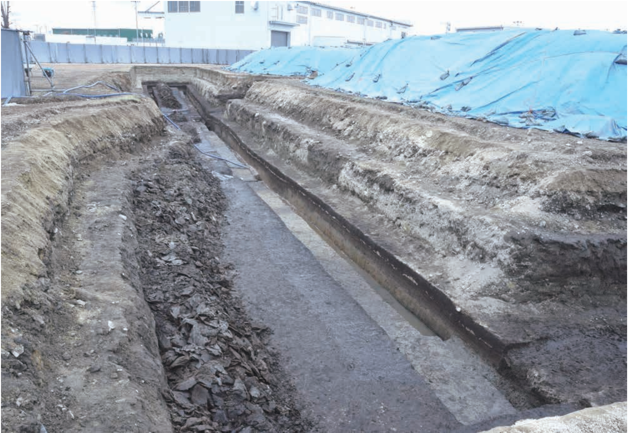
B区調査完了状況（南東から）
