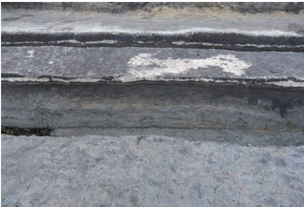
C区東側北壁断面②（南から）
