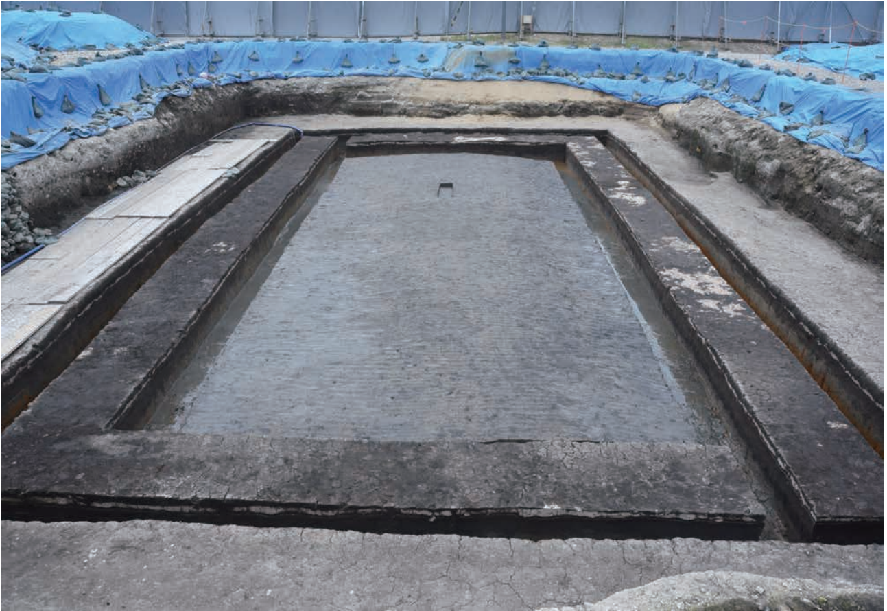
C区東側調査完了状況（南から）
