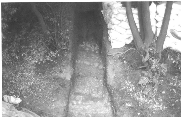
2. 第Iトレンチ全景（西北より）
