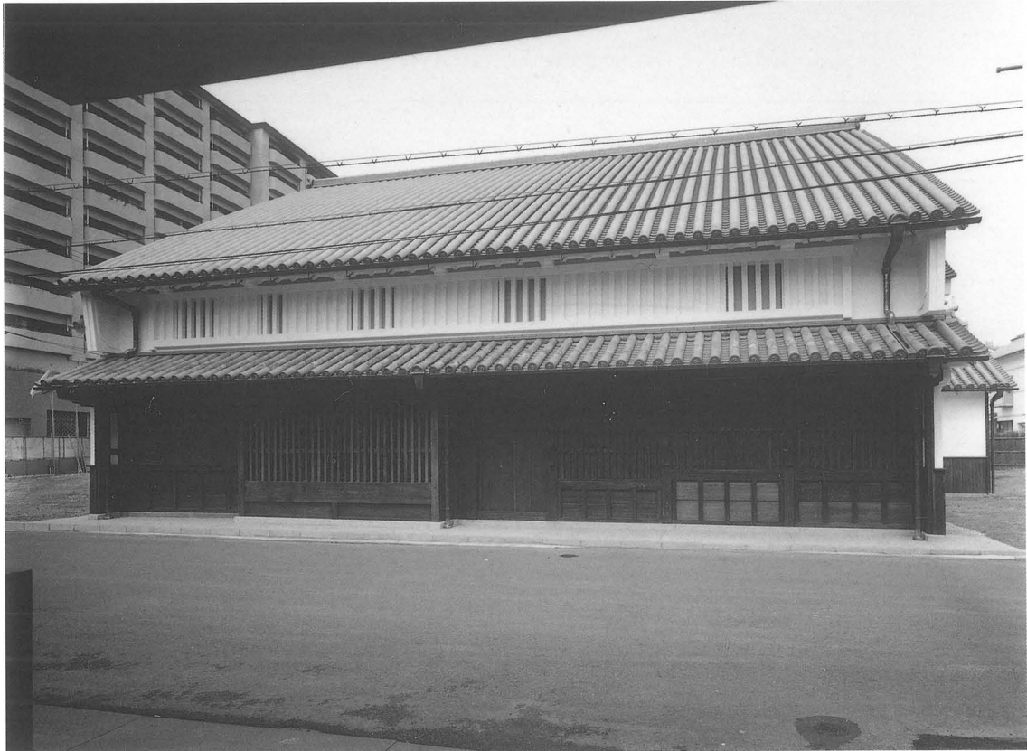
1. 旧岡田家酒蔵店舗南面（解体修理後）
