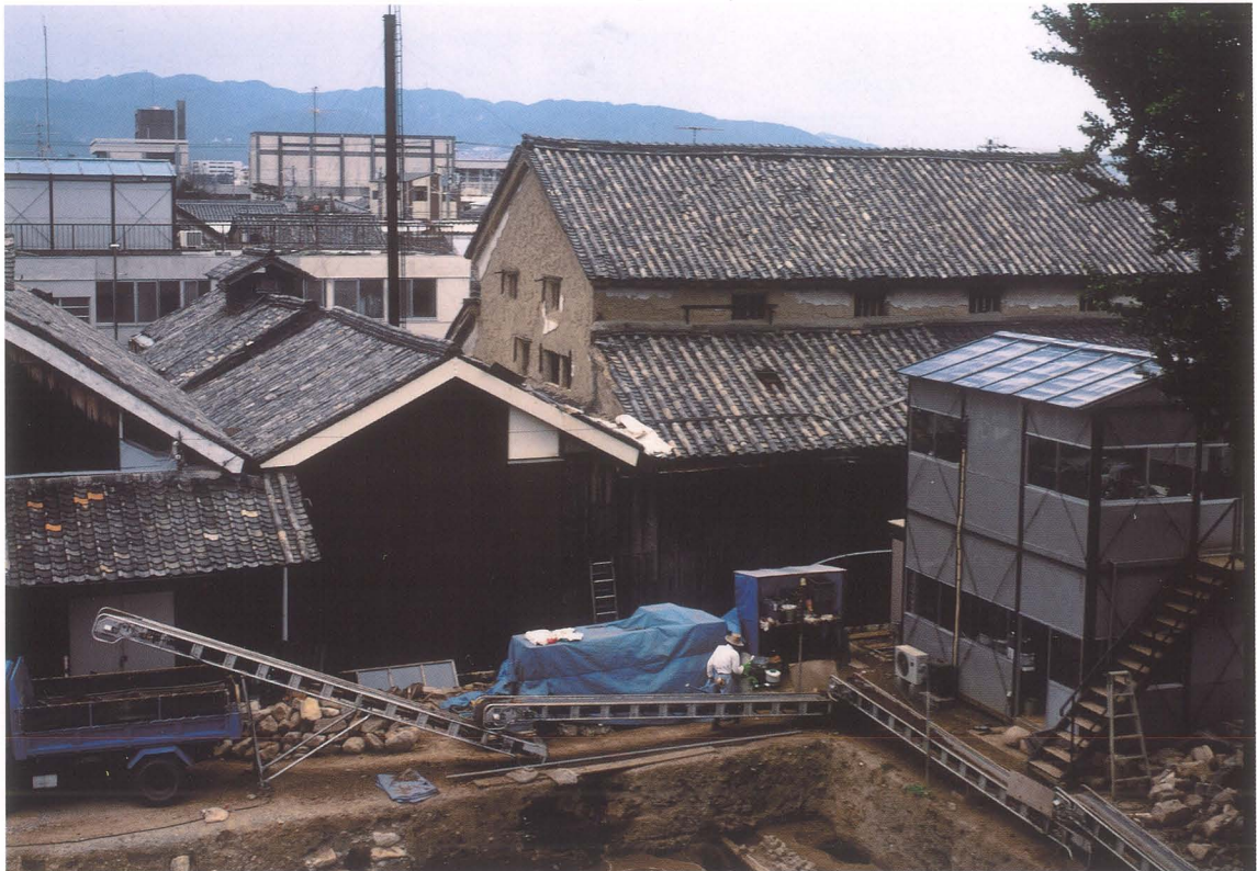
1. 調査区より旧岡田家店舗・釜屋・酒蔵を見る（東より）
