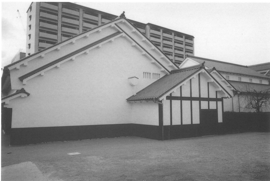
1. 旧岡田家酒蔵店舗・釜屋・酒蔵東面（解体修理後）
