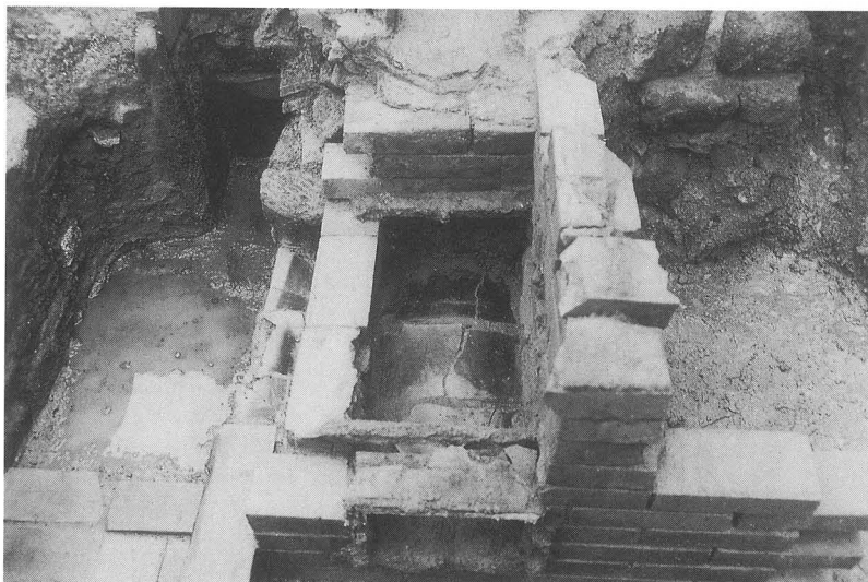
3. 竈1 へっつい3解体時（南より）
