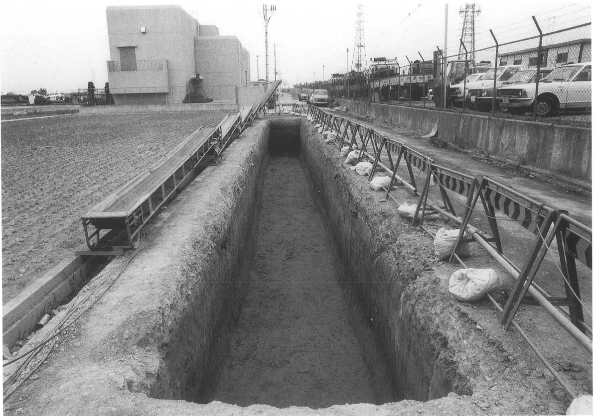
第6次調査 第1トレンチ 完掘状況 (北より)
