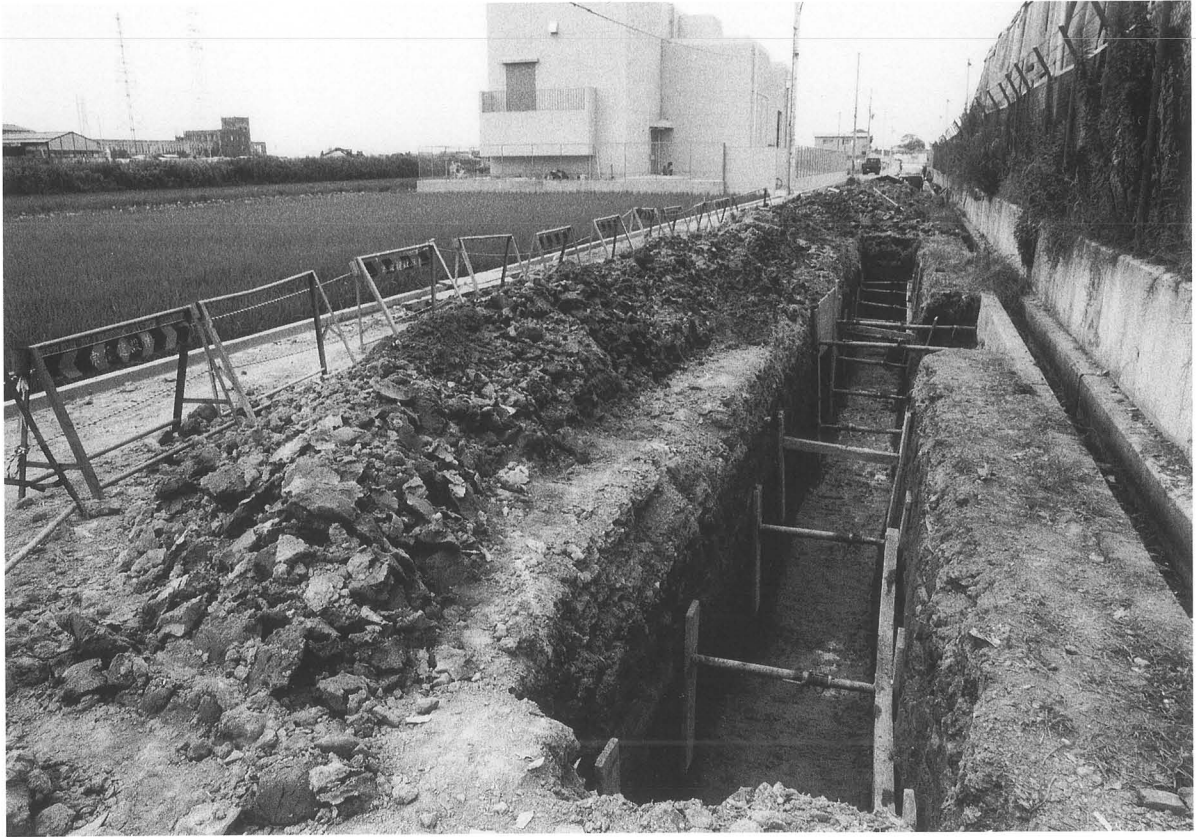
第3次調査 Aトレンチ発掘状況
