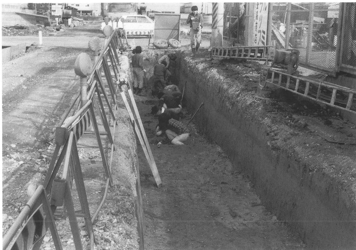
第6次調査 第2トレンチ 発掘風景（南より）
