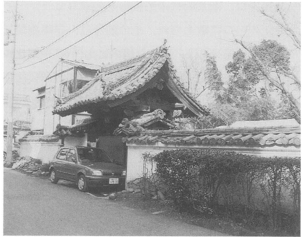
写真1. 遍照院の現況
