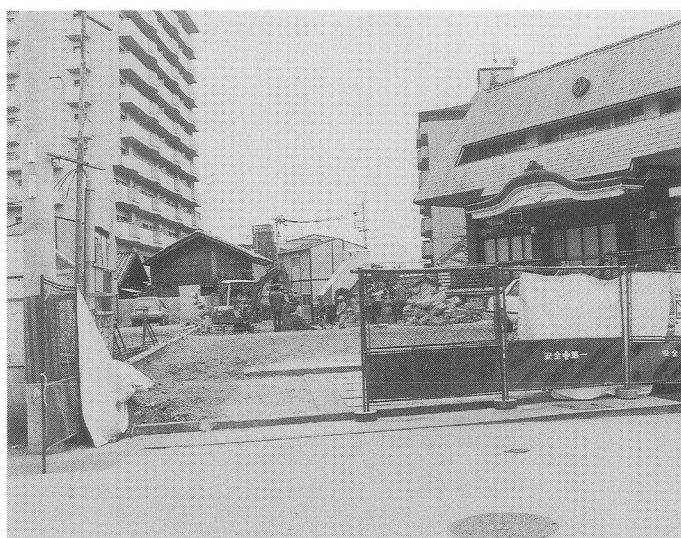
写真11. 調査区遠景(北より)
