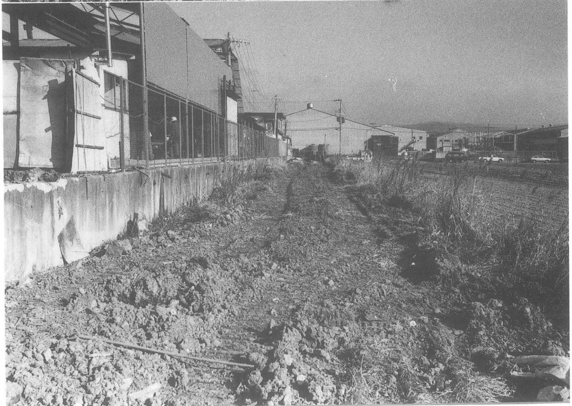
調査地全景 上：A区(東より) 下：B区(南より)
