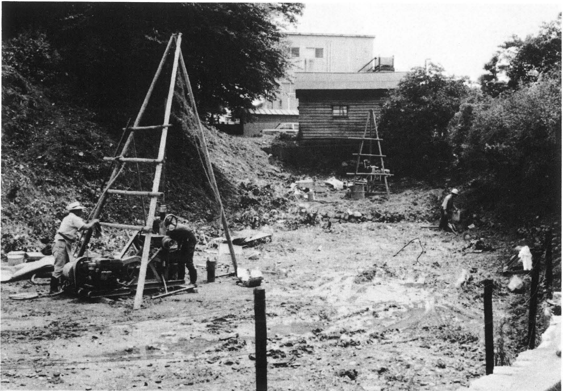
ボーリング調査の状況
