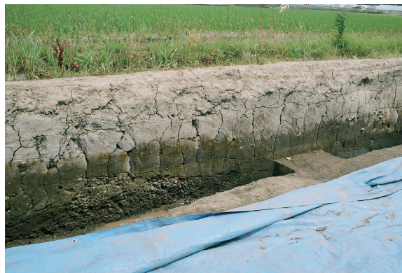
調査区東壁(北西より)
