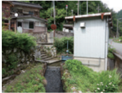
図 14 イトバ (No.1) と消雪用ポンプ場
