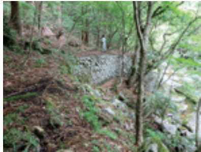
図9 8 発電所南東のピア
