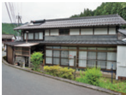
図12 2階建瓦葺の主屋
