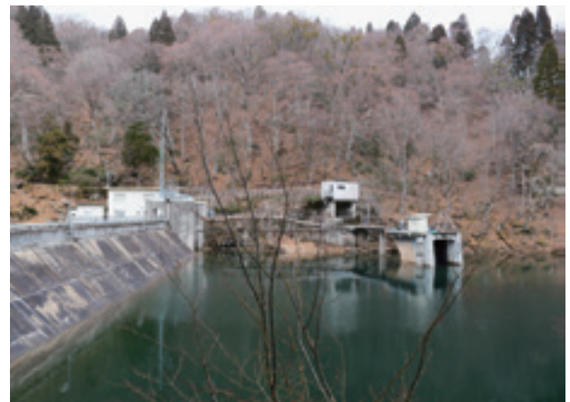
図6 三滝ダム北側の県有地
