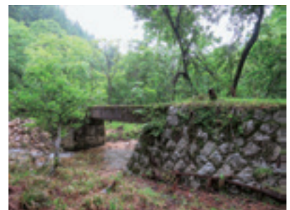
図19 18 林道分かれコンクリ橋
