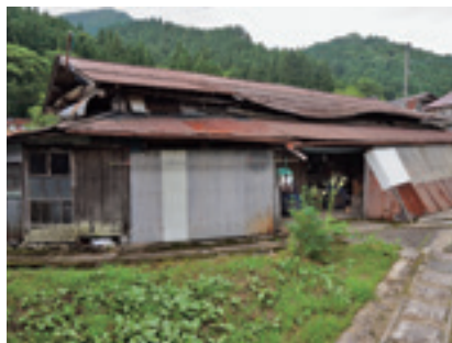
図9 平屋建鉄板葺の主屋
