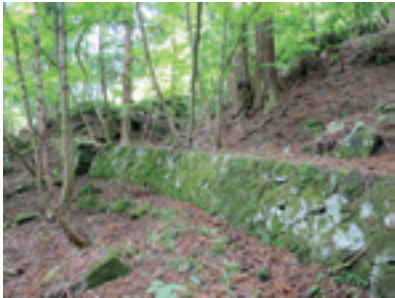
図8 7 発電所南東で川を渡った南付近の軌道跡の石積み
