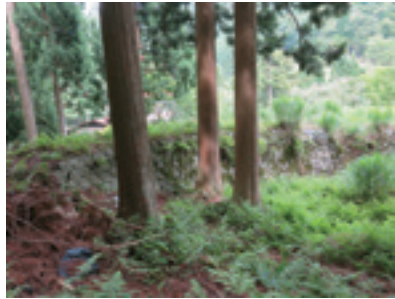
図6 5 倉谷土場付近のヘアピンカーブの石積み
