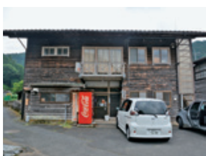
図 26 芦津部落事務所事務所棟
