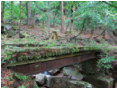
図14 13 昭和10年製作の橋
