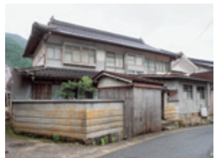
図13 2階建瓦葺の主屋
