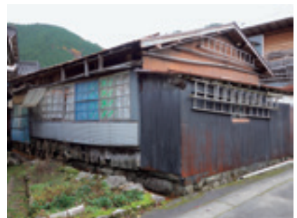
図10 平屋建鉄板葺の主屋
