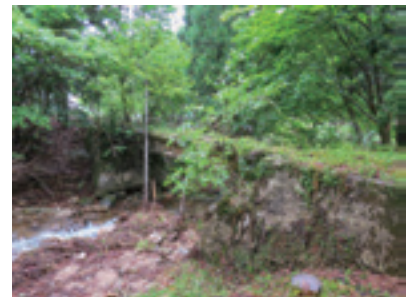
図16 15 中電雨量計近くの橋
