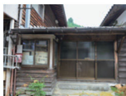
図 28 芦津部落事務所繋ぎ部
