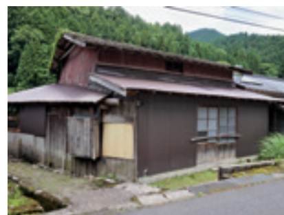
図 16 平屋建鉄板葺の付属屋
