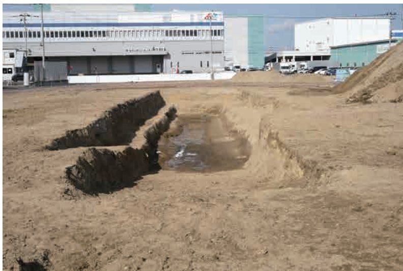
2トレンチ 完堀状況 (南から)
