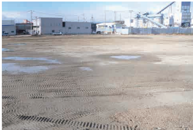
埋戻し後の状況（東から）
