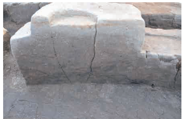
SB 8 A P23 (Tライン)
