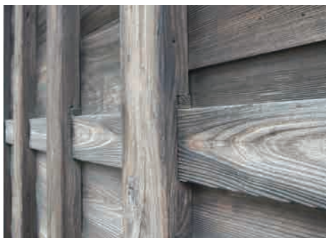
壁板部分拡大（同右）
