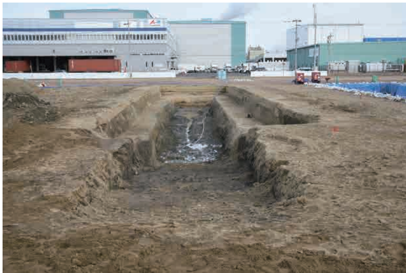
3トレンチ 完掘状況
