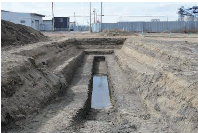
5トレンチ 完堀状況（東から）
