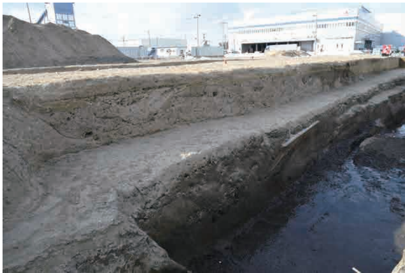
4トレンチ 西壁
