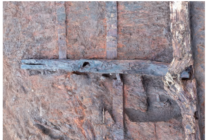
6 11-1区1面1号建物1号壁建築部材出土状況(南から)
