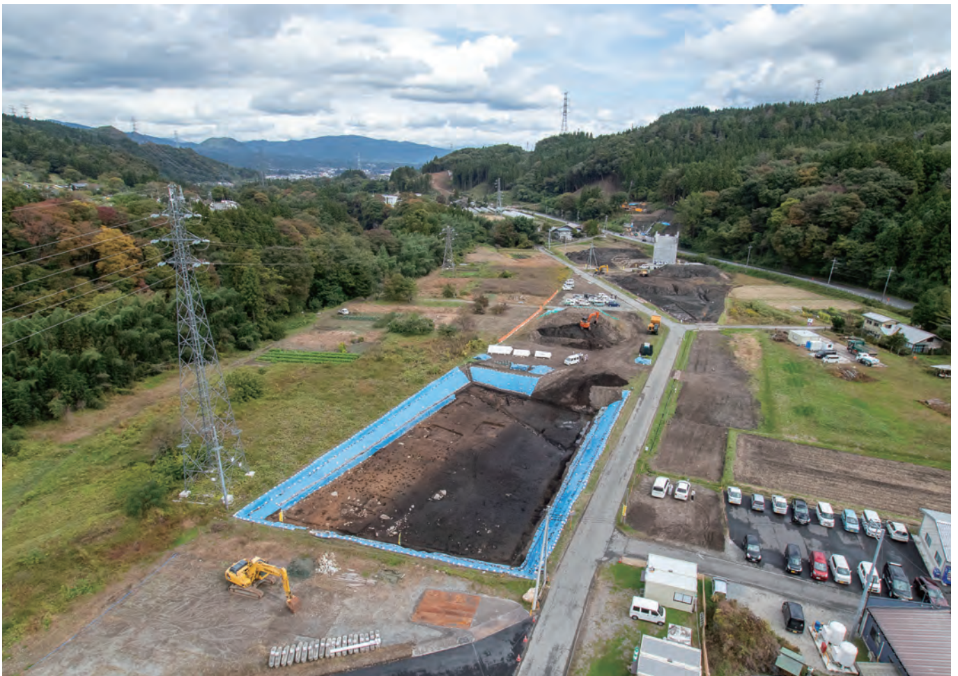
2 11区3面遠景(西から)
