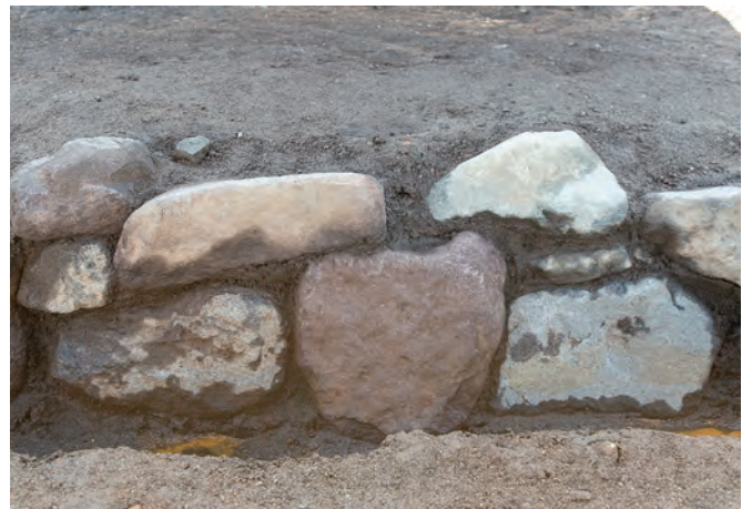
4 15区1面58号溝石積み近撮(北から)
