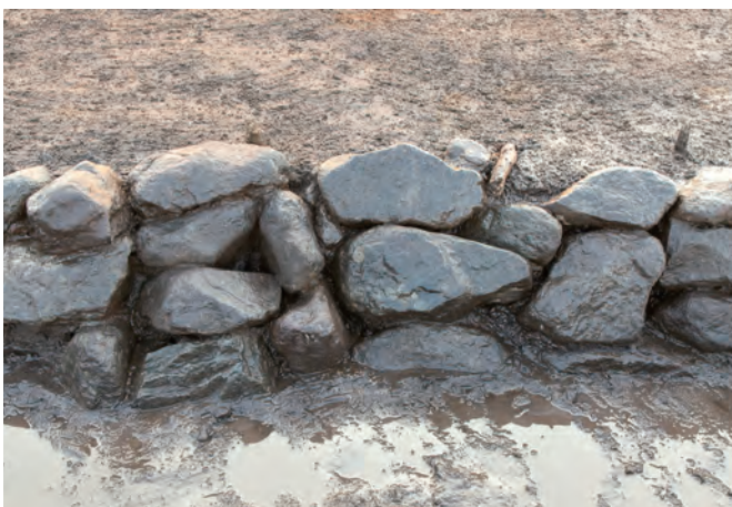
4 11-1区1面60号溝石積み状態(東から)
