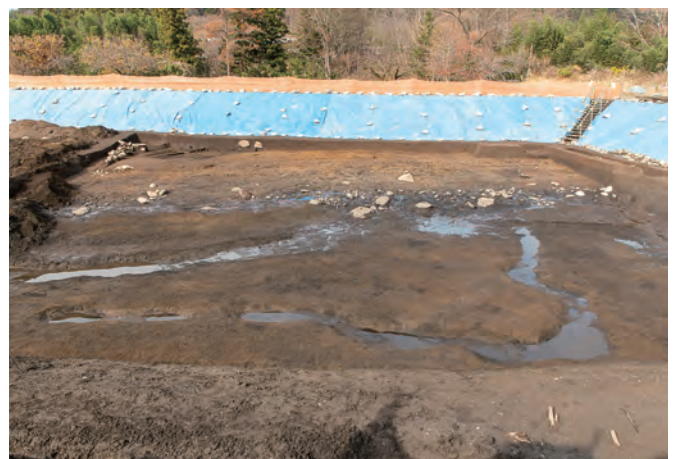
8 11-1区2面3号自然流路(南から)
