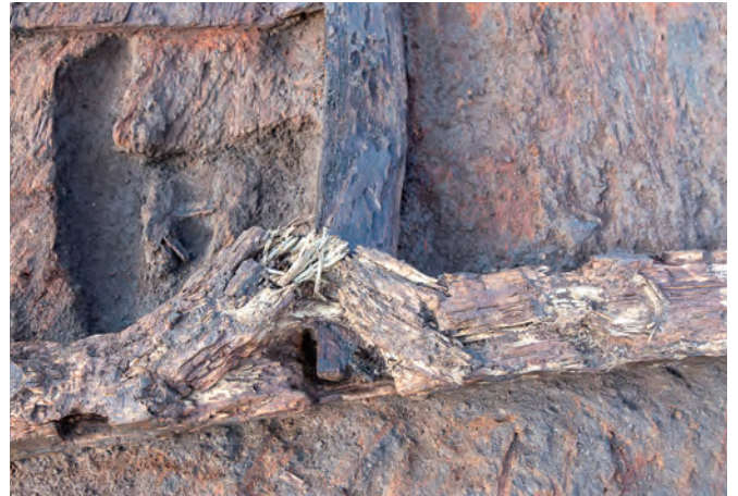
4 11-1区1面1号建物1号壁建築部材ホゾ周辺(東から)
