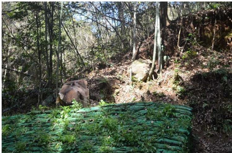
R5 年度施工箇所上部 樹木根の腐食による崩落及び、花崗岩円礫の転石危険箇所
