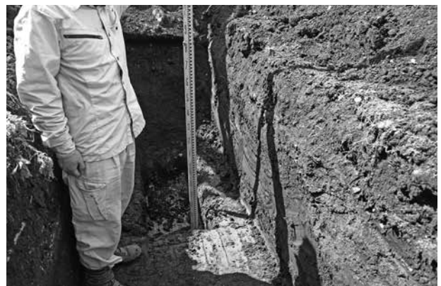
試掘坑深堀り② (北から)
