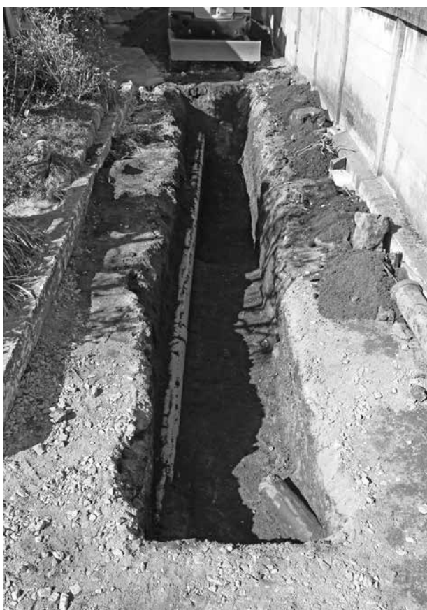
試掘坑全景 (南東から)
