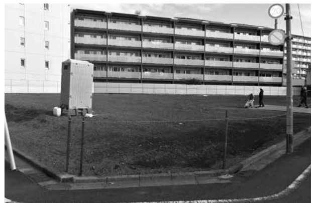
敷地全景 (南西から)
