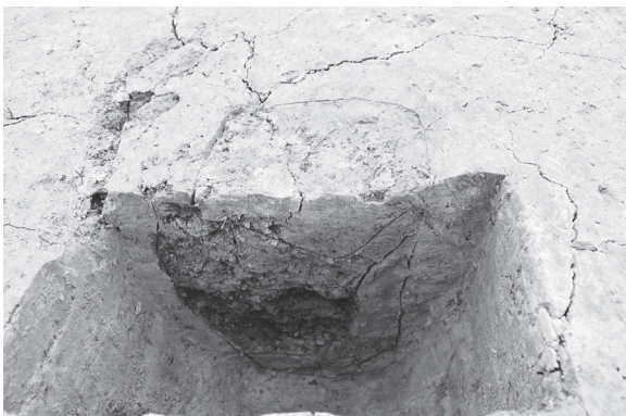
写真 19 SB3 P3 断面 (東から)
