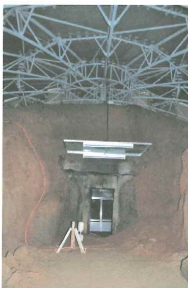
永安寺西古墳保護施設内
