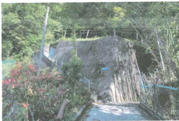
大坊古墳保護施設（南から）
