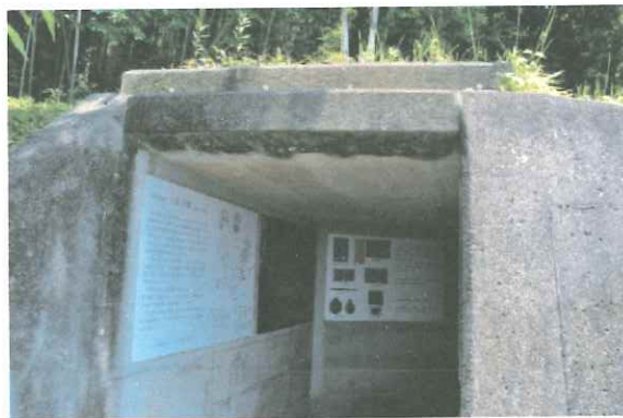
大坊古墳見学室アプローチ
