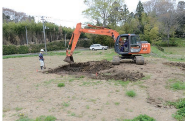
2. 重機による表土除去（南東から） [Z9641]
