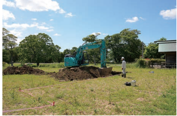
2. 重機による表土除去（北西から） [Z9460]
