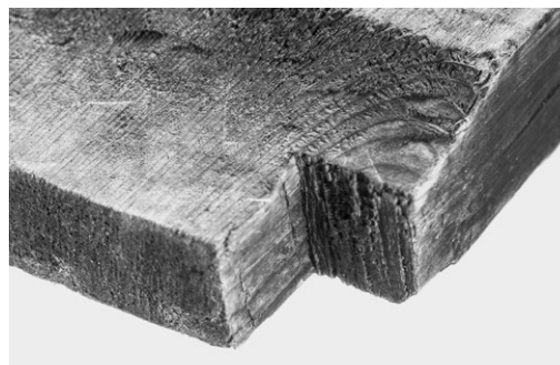
図115 横板F1 下面の欠込
