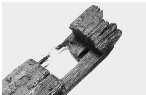
図111 土居桁（南側）の相欠仕口・ホゾ穴
