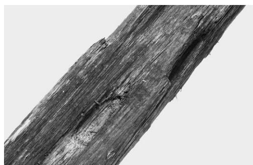
図113 土居桁（北側）のダボ穴
