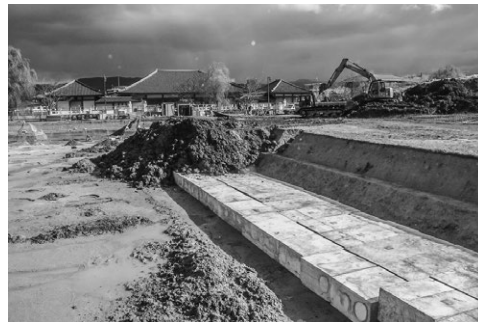
図26 第478次調査区との重複部分に埋めた軽量材発砲スチロールの再検出
