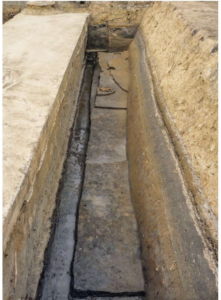
4：第515次調査区（南区）ボックスカルバート西側全景（北から）
