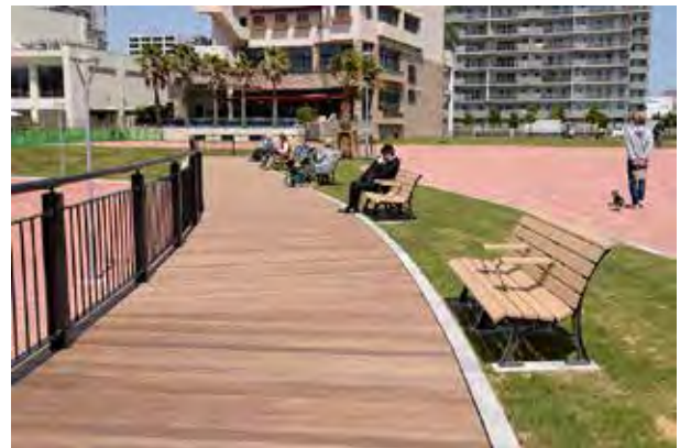
千葉中央港旅客船棧橋（メーカー HP より）
