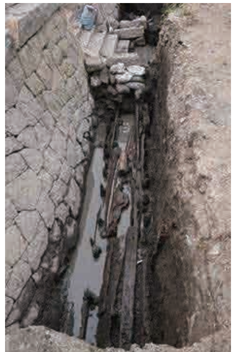
石垣護岸及び板材検出状況(南から)
