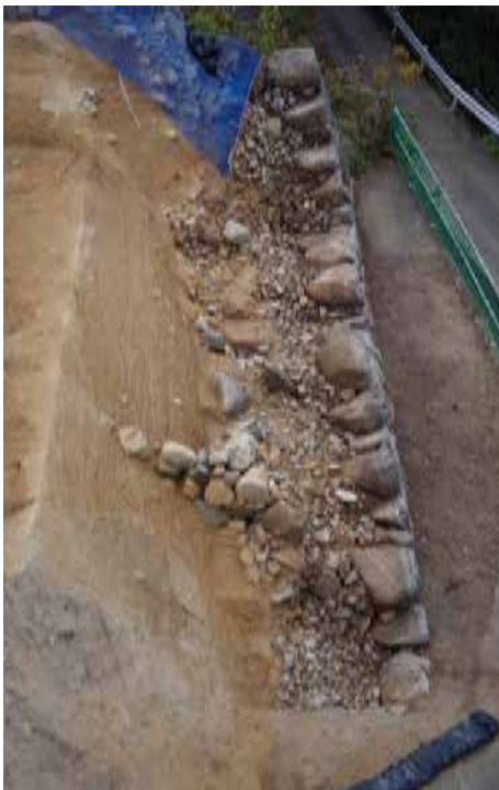
石積み・旧石垣検出状況(南から)
