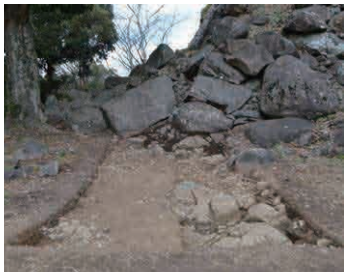
弾正丸南東隅角部石垣発掘調査状況
