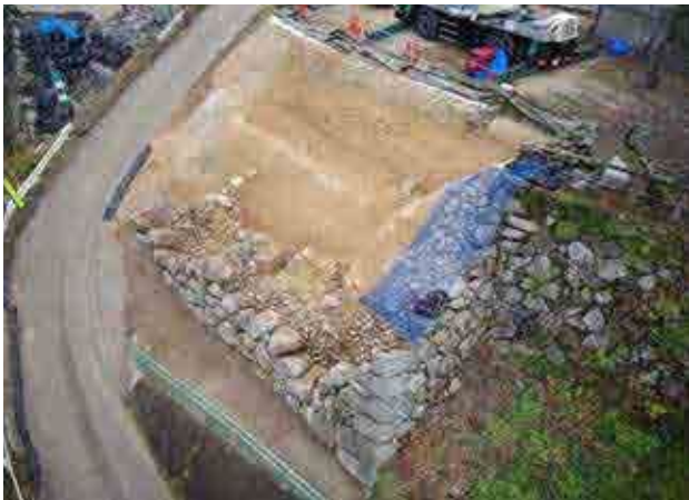
15面上段・16面石垣解体状況(北東から)
