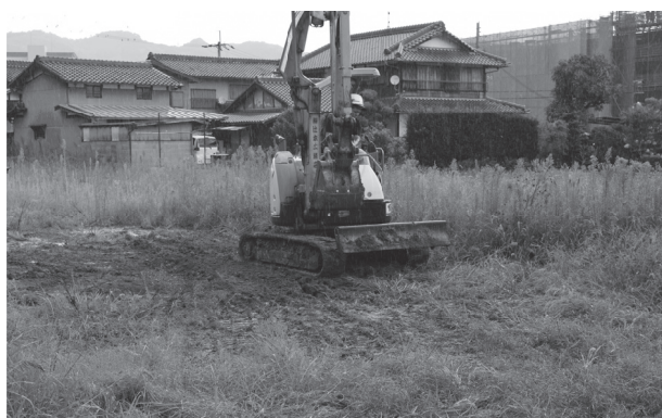
調査後埋戻し作業風景 (南西から)
