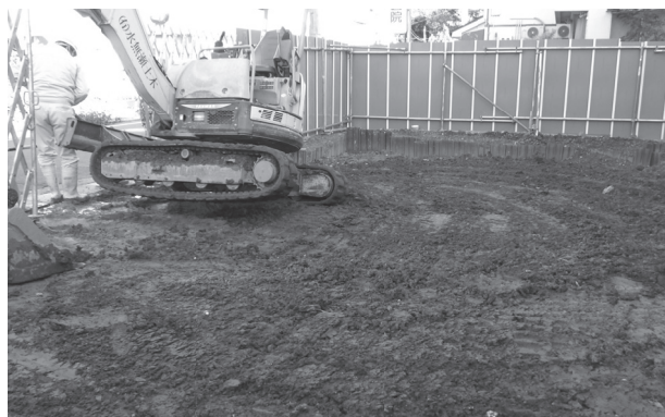
調査後埋戻し状況（西から）
