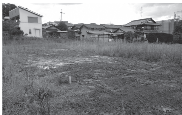
埋戻し状況 (南西から)
