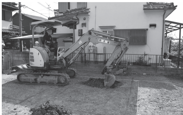
HS 23-1 調査グリッド掘削風景 (西から)
