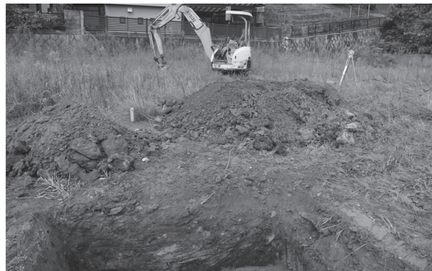
調査グリッド掘削状況 (南から)
