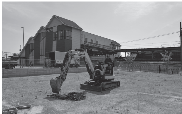
1 G掘削開始風景 (南西から)
