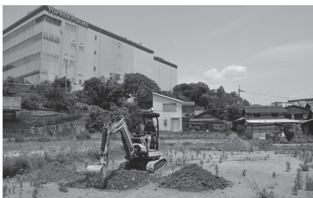
3 G 掘削状況 (南東から)
