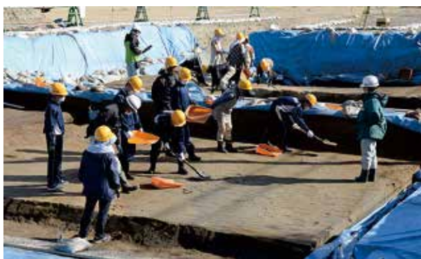
河川跡の掘り下げ作業
