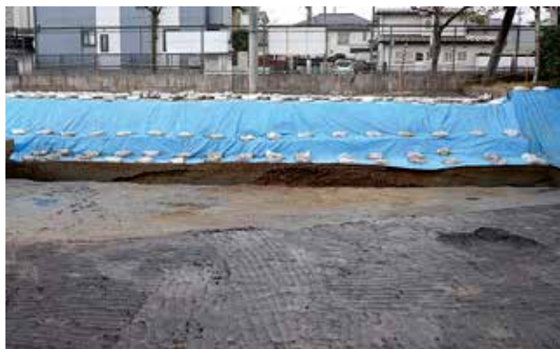
2区 西側 南壁(北から)
