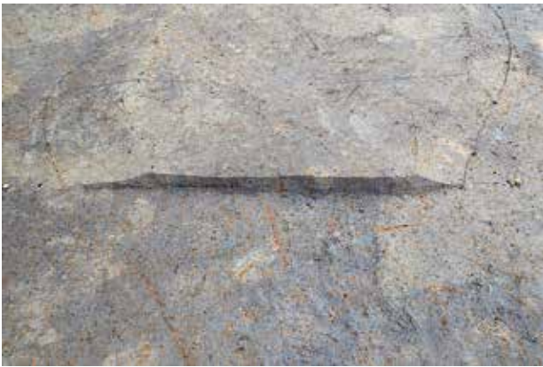
畦畔31 断面(東から)
