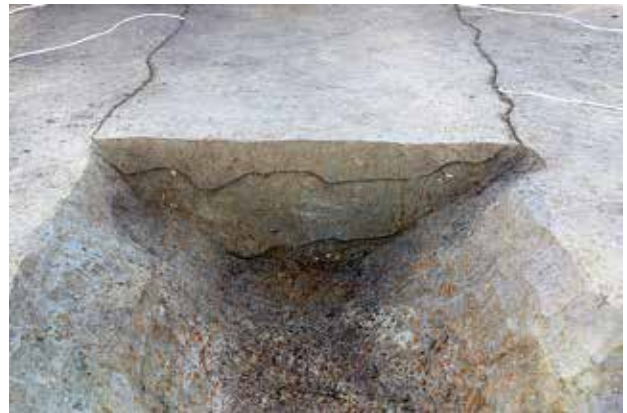
SD10 断面(北東から)
