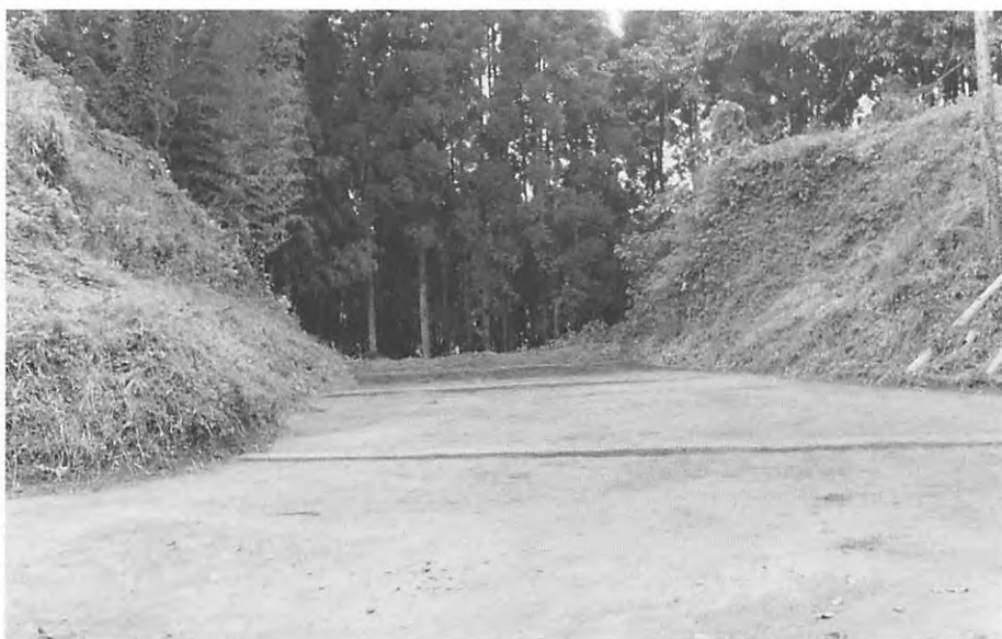
(2) 表土剥ぎ終了状況（北より）
