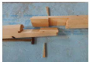
柱根継ぎ模型(金輪継ぎ)
