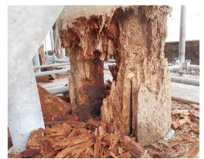
柱材(根元)腐朽状況
