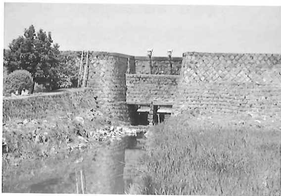
写真35 二枚戸海側①(東から)
