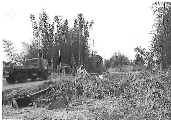
写真15 亀甲遺跡調査地近景(南から)
