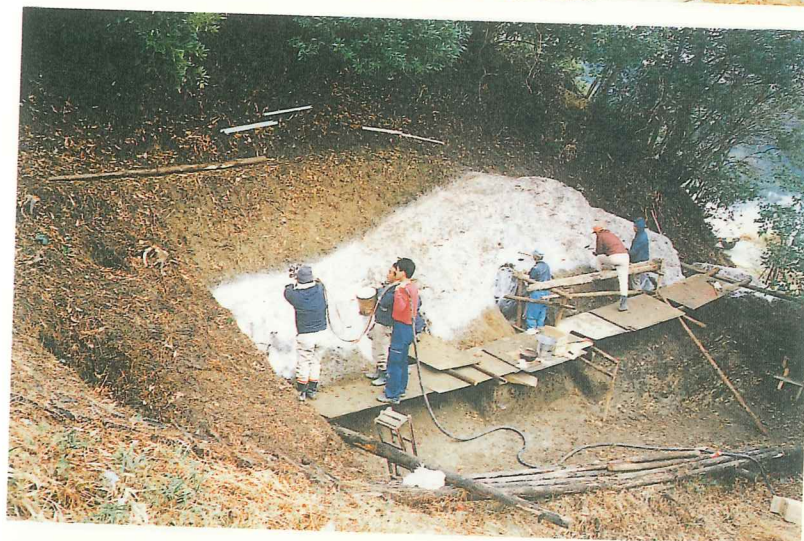
図版56 2～5号横穴 ガラス繊維混入 FRP吹き付け
