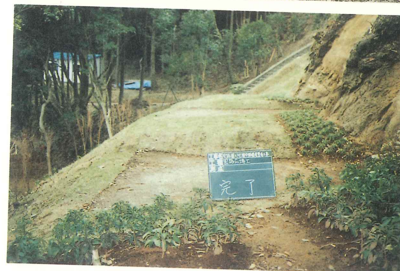
図版90 9～11号横穴 横穴前庭部修景 完成
