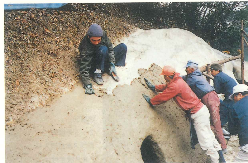
図版59 2～5号横穴 ステンレス金網取り付け後 サイト擬土貼り付け
