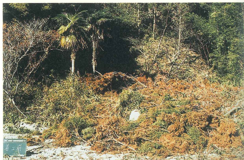
図版107 53号横穴 前庭広場修景 着工前
