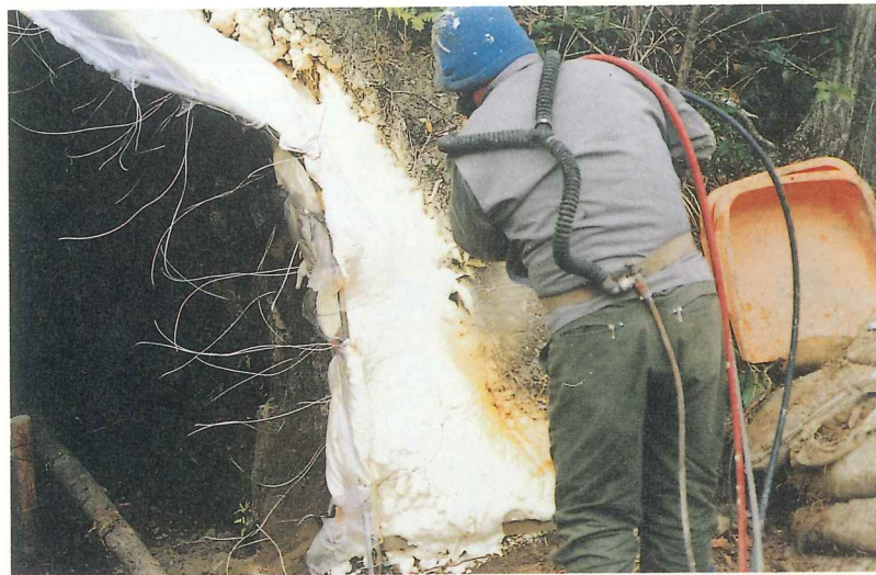
図版76 13号横穴 発泡ウレタン吹き付け
