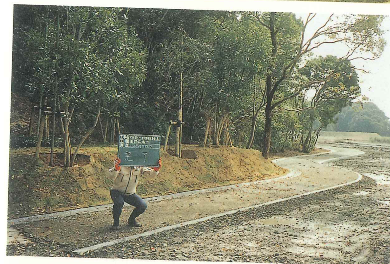
図版88 6～8号横穴 前庭部修景及び見学道 完成
