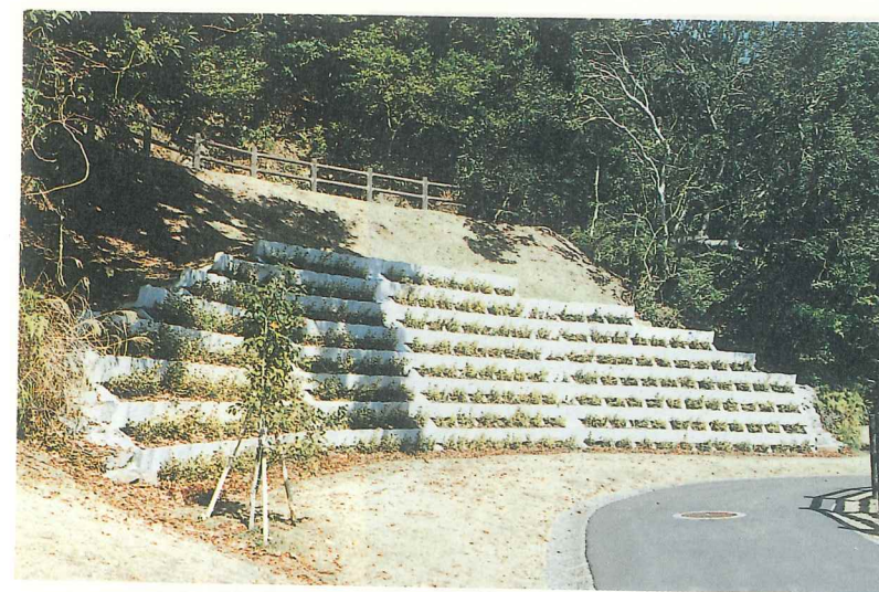
図版110 36~39号横穴 前庭部補強 完成
