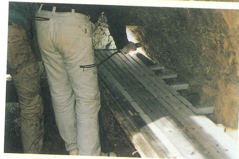
図版80 13号横穴 床面被覆板設置状況
