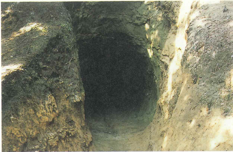
図版64 12号横穴 保存工事着工前
