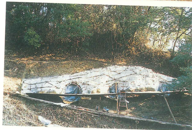
図版57 2～5号横穴 ステンレス骨組み
