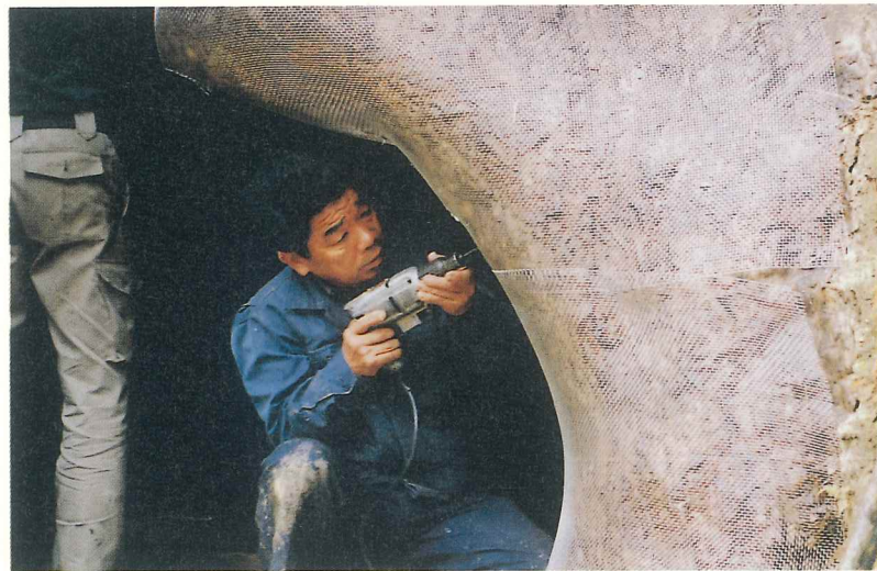
図版83 69号横穴 ステンレス金網取り付け
