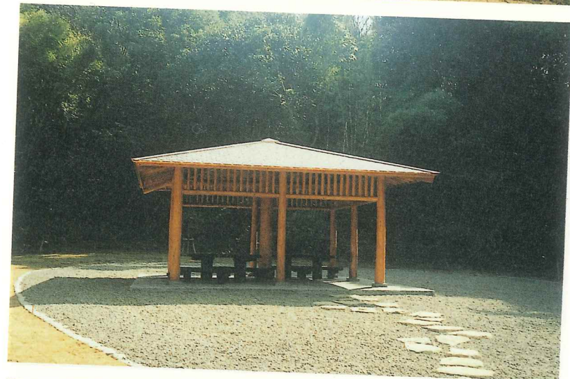
図版94 70～72号横穴 前庭広場修景及び四阿 完成
