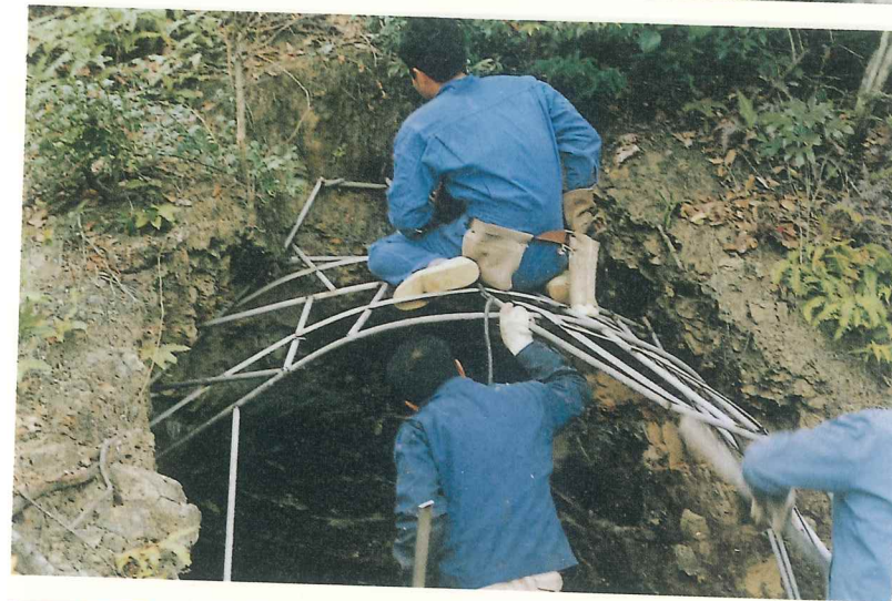
図版74 13号横穴 ステンレス骨組み (菱道部復元)
