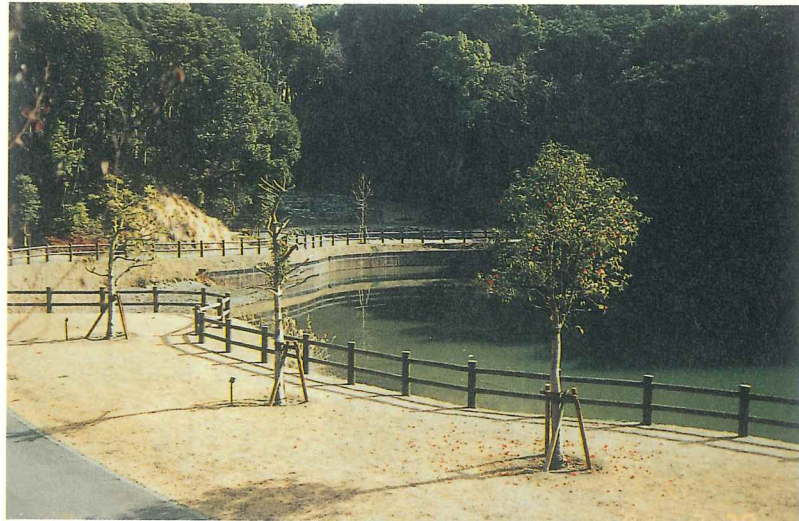
図版123 稲荷池奥広場修景 完成
