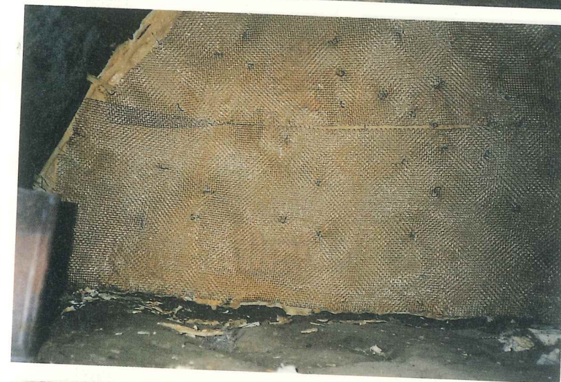
図版62 9号横穴奥壁 ステンレス金網取り付け
