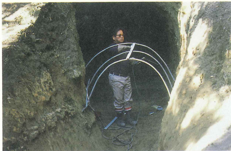
図版65 12号横穴 ステンレス支柱取り付け
