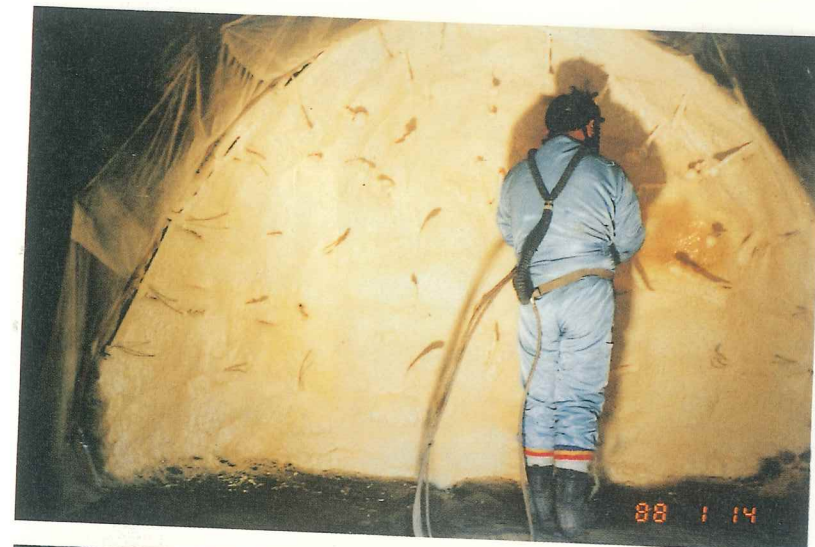
図版61 9号横穴奥壁 ウレタン吹き付け
