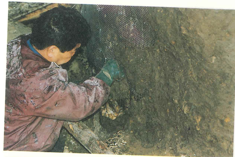
図版79 13号横穴 羨道内部エポキシ擬土 貼り付け
