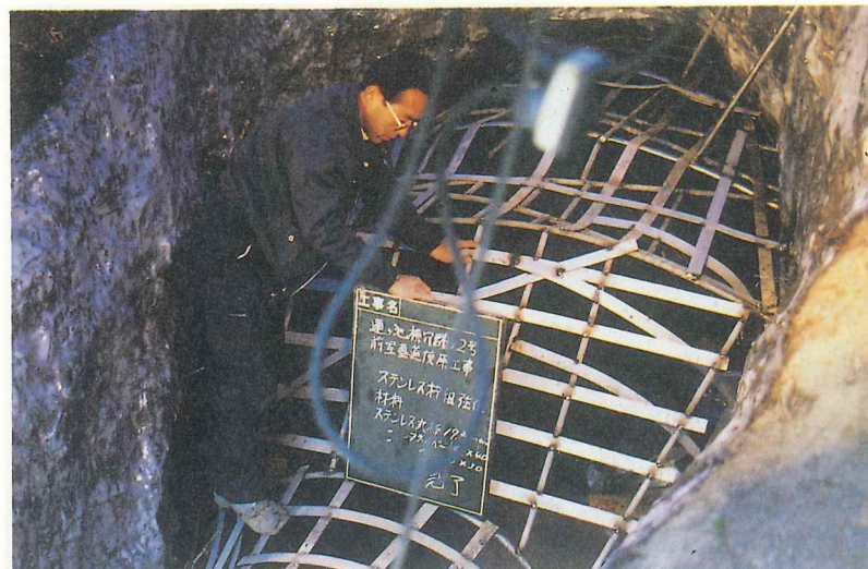
図版66 12号横穴 ステンレス骨組み
