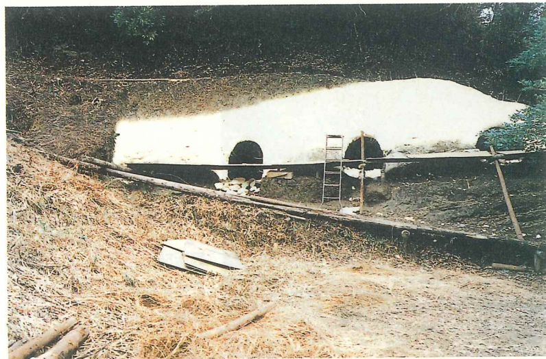
図版58 2～5号横穴 発泡ウレタン吹き付け
