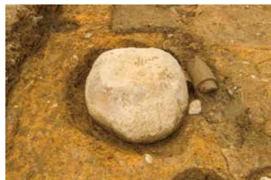
第 27 図 礎石に残る円柱の当たり痕と被熱痕（北から）
