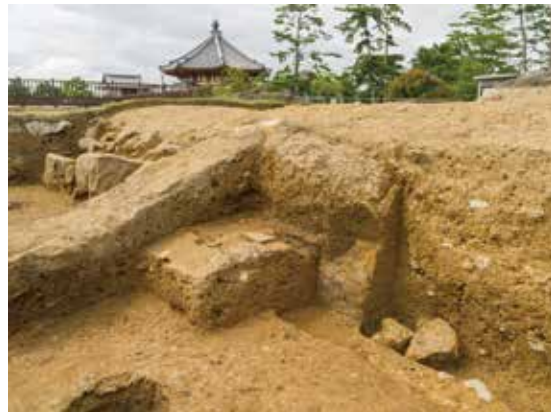
第 4 図 羽目石 SX11408（北東から）
