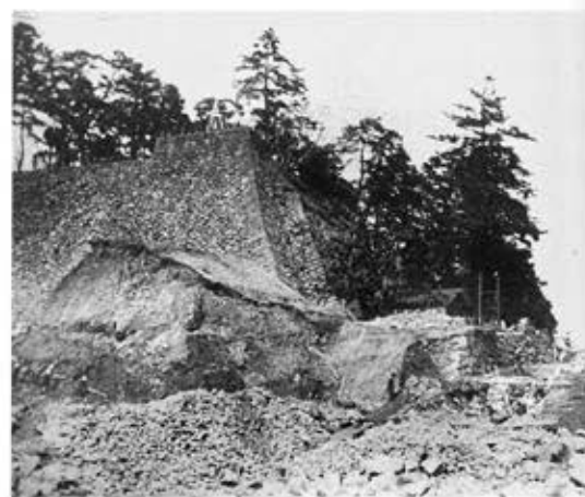
図-18 明治の南面高石垣の崩壊 (金沢市立玉川図書館蔵)
