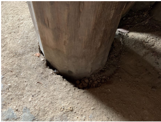
第1図 地震による被害（9号住居）
