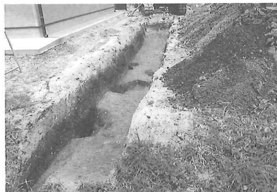
写真51 蓮華遺跡4T遺構検出状況 南から
