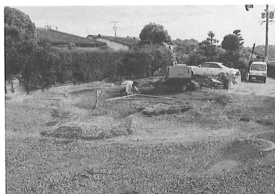
写真12 立願寺廃寺調査地全景 西から
