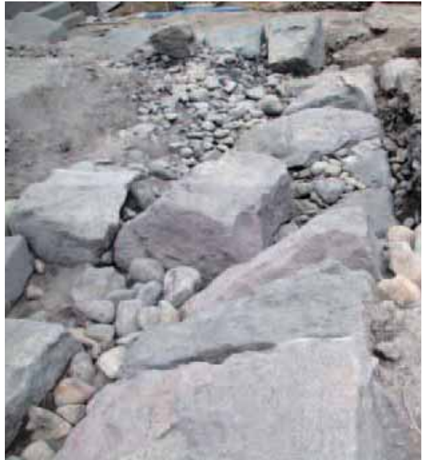
3230S(ニラミ櫓台南面)・石垣台(Ⅱ期) 西から
