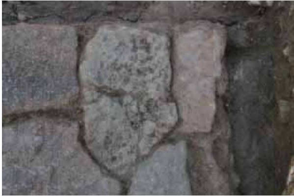
SD002(石組溝)底板 東から
