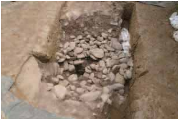
P006 (礎石根固) 西から
