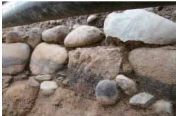
SD010 (石組暗渠) 北東から
