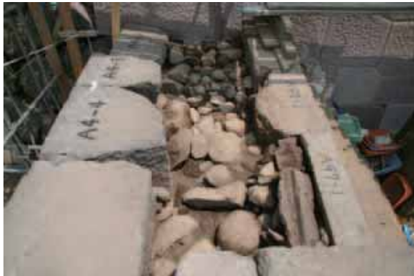
一ノ門 (東側) 裏込め 西から
