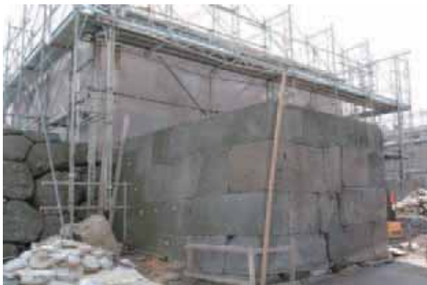
一ノ門 (東側) 積み直し完了 北西から
