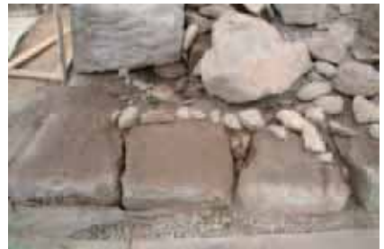
石材解体後（角度調整の川原石）
