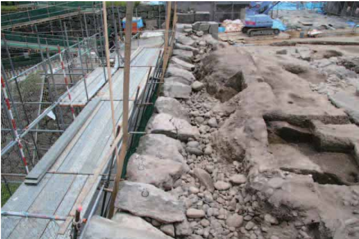
3500N（ニラミ櫓台） 解体後 西から
