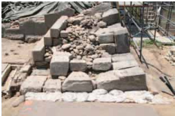
一ノ門 (西側) 解体終了 東から
