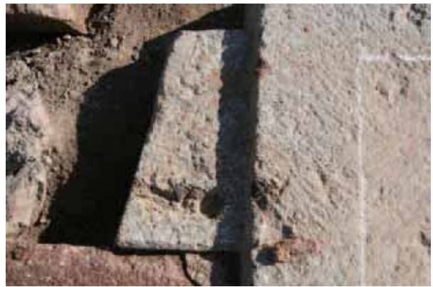
P005 (門礎石) 西から
