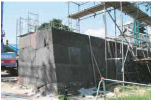
一ノ門 (西側) 積み直し完了 北東から
