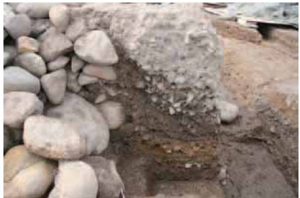
SW001(長屋台石垣) 東から
