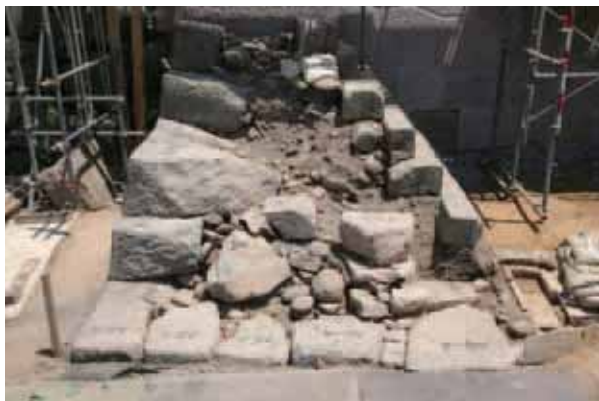
一ノ門 (東側) 解体終了 西から
