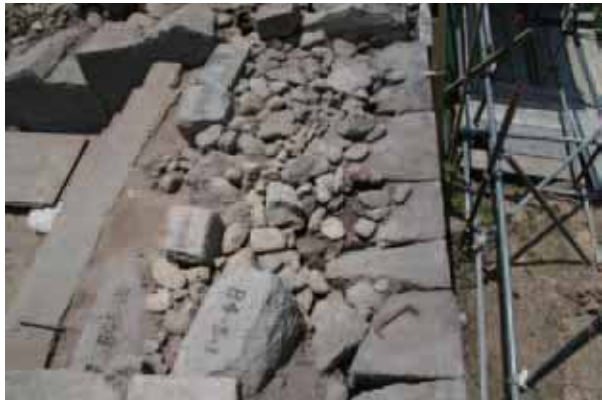
一ノ門 (西側) 裏込め 東から
