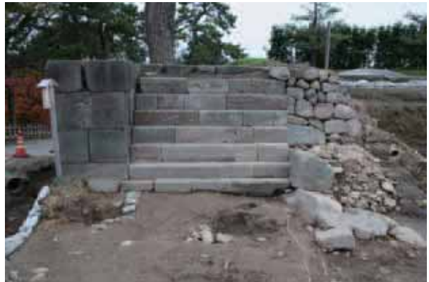
SX026(東側類当石垣階段) 南から
