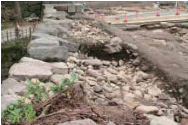
解体前 裏込め表土堆積状況 西から
