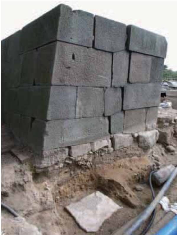
3241W(東側類当石垣西面) 北西から
