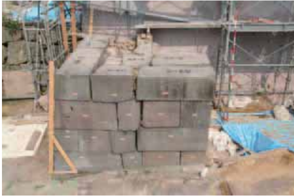
3241 (一ノ門東側) 解体調査前 西から
