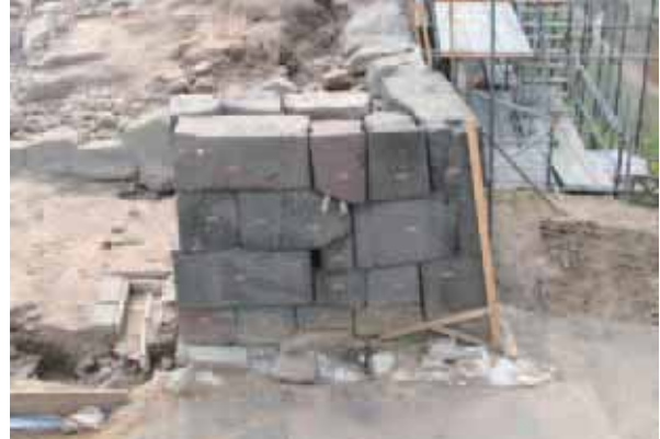
3231 (一ノ門西側) 解体調査前 東から
