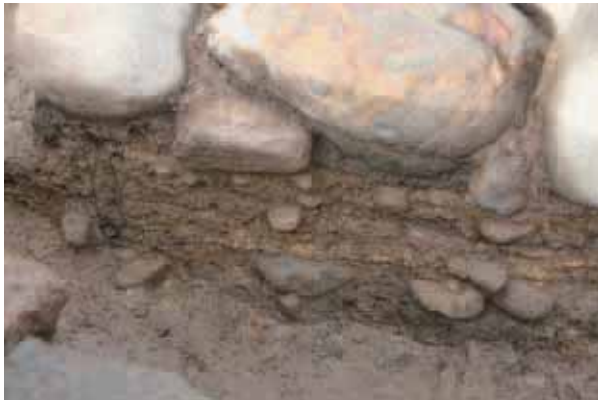
3220S(土塀裏盛土土留石垣) 南から
