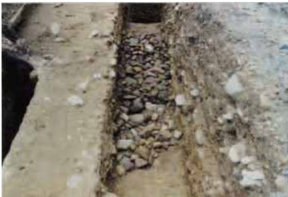
礫集中遺構 北から
