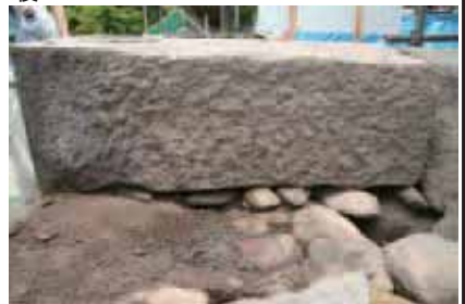
石材後面 (角度調整の川原石が入る)
