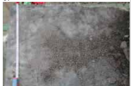
石材解体後（細かな礫が広がる）
