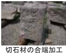
切石材の合端加工
