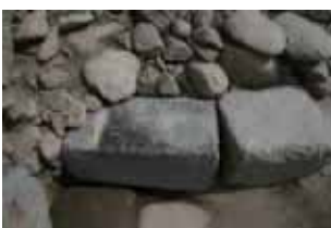
溶けた鉛が付着した雁木石（裏込めに転用）
