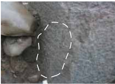
⑥ 面に鉛滴が付着する根石 現状は根石 宝暦の大火の時点は築石として利用
