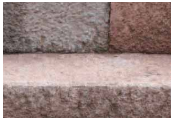
雁木石端部（面取り）加工状況 西から
