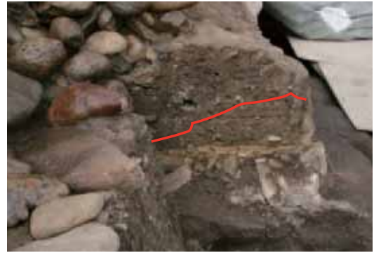
④ 3240W (北側石垣台西面)の背後の掘方 石垣掘方は盛土層を掘込む。掘方内は栗石と土が鋸歯状に堆積
