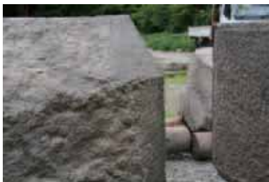
切石材の合端加工
