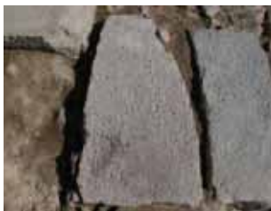
36(北西角石): 戸室石 上面に細かいノミ痕あり 石尻がすぼまる
