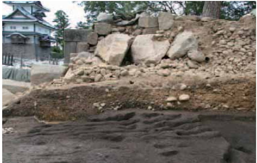
⑦ 3240W (北側石垣西面) 背面
