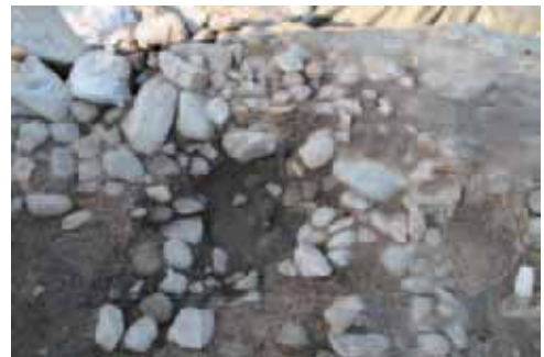
① T004攪乱土を除去した状態 南側石垣台の裏込め栗石が周辺に広がる。
