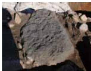
20(南東角石): 戸室石 上面に粗くノミ痕あり
