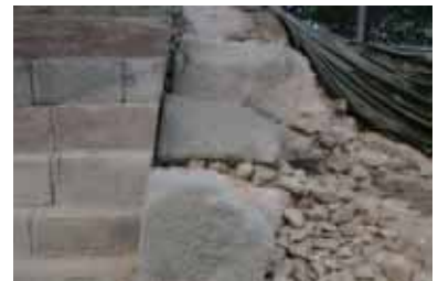
③ 割石材の側面及び上面に合端加工を行い切石材を積む
