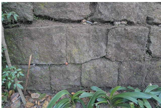
写真1 石垣（亀甲崩し積み・間知石）
