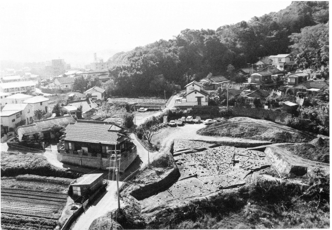
b. 同上（北東から）
