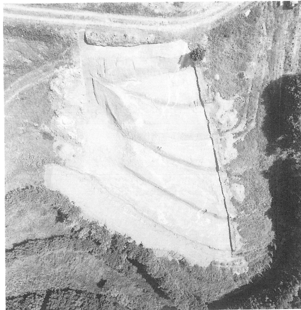
A 地区 B 地点全体写真
