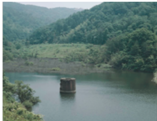
現存する取水塔
