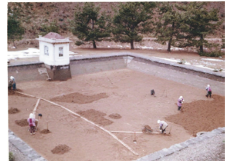
洗浄した砂を敷き直しているところ
