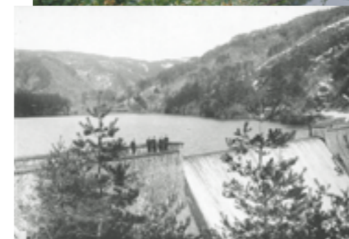
昭和初期頃の堰堤
