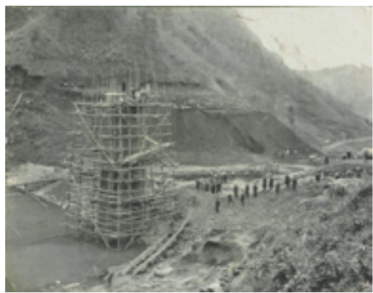
工事中の取水塔
