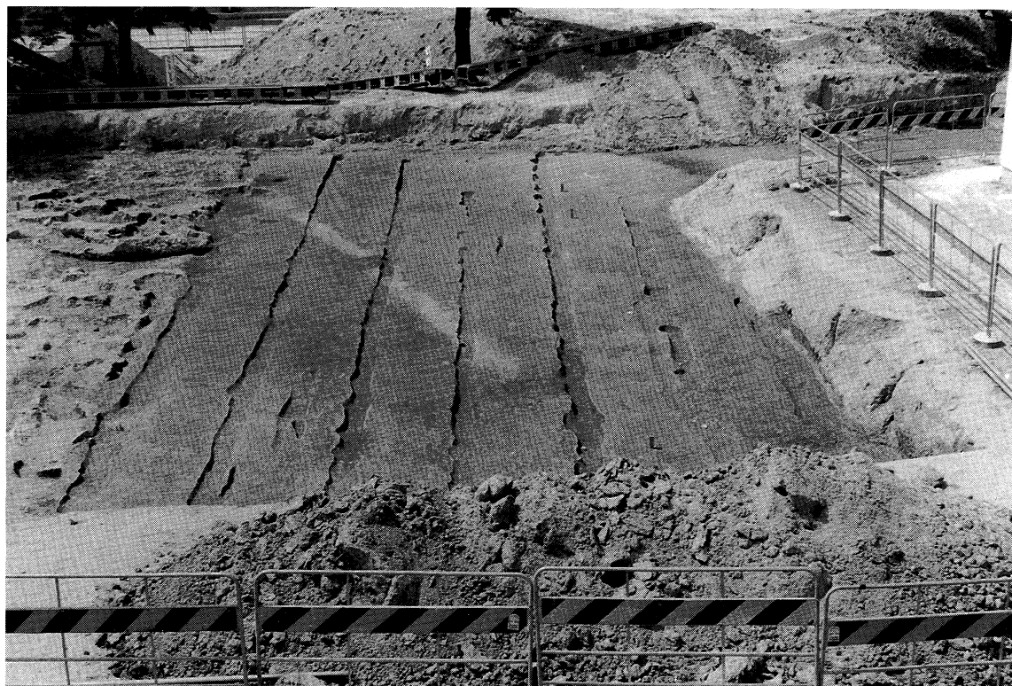
b. 遺構検出状況（南から）
