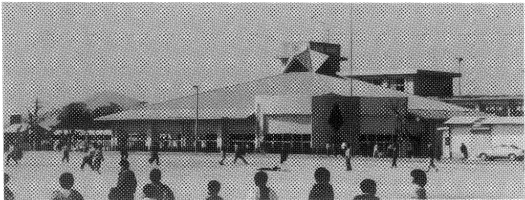
第24図 竣工した大食堂(平成5年3月)
