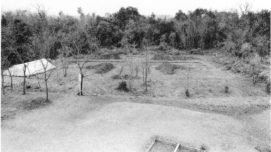
Fig. 3 トレンチ設定状況（東から、手前は指定地）
