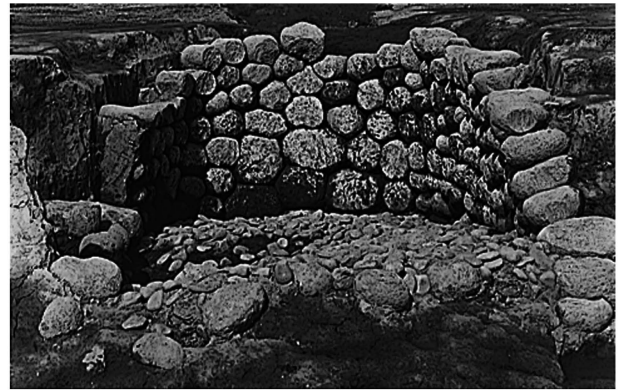
第10号墳石室奥壁
