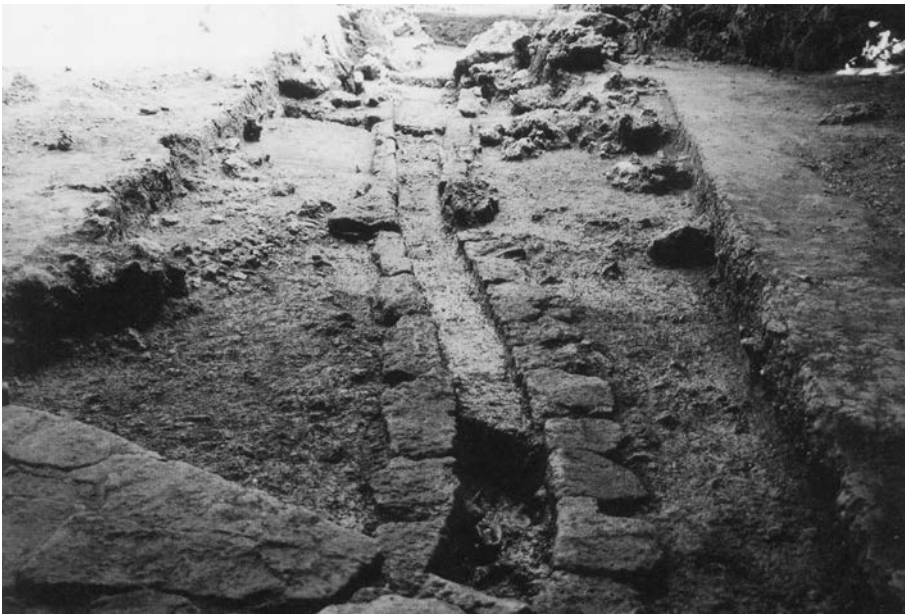
三庫理の排水遺構
