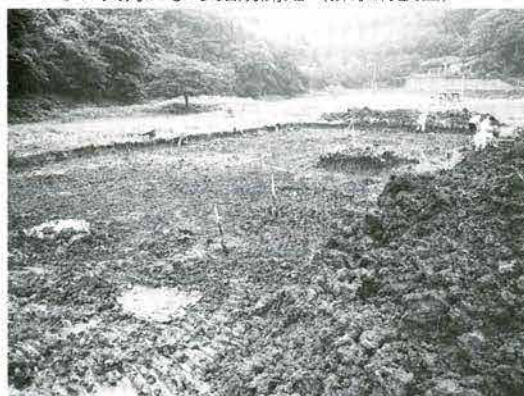
▼ 3. 人力による掘削開始 (排水溝設置)
