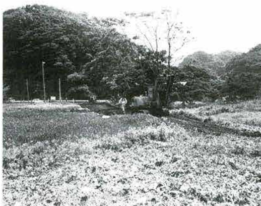
▶ 1. 低湿地に搬入用仮設道路を設置
